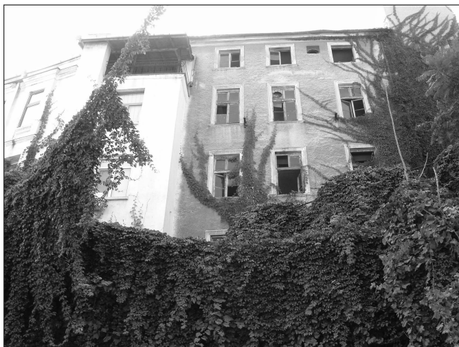
Източната фасада на тютюневата фабрика
